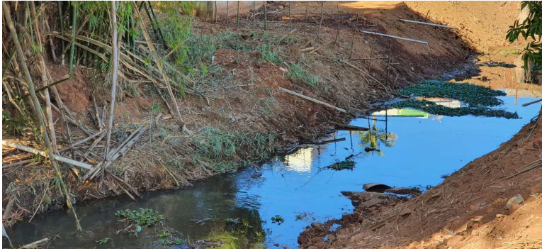
Figura 7: Esgoto sem nenhum tratamento sendo despejado no curso d'água.
