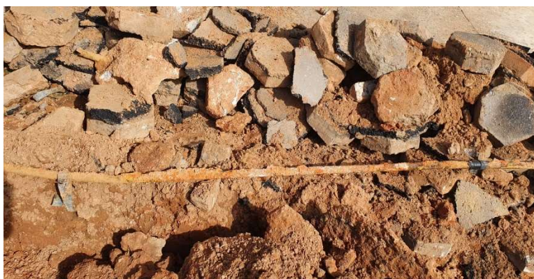
Figura 13: Encanamento de ferro por onde ocorre a distribuição de água
