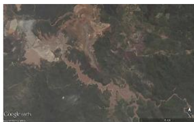
Figura 2: Complexo das barragens de Fundão/Santarém/Germano, e a localidade de Bento Rodrigues, em novembro de 2015, após o rompimento de Fundão.
